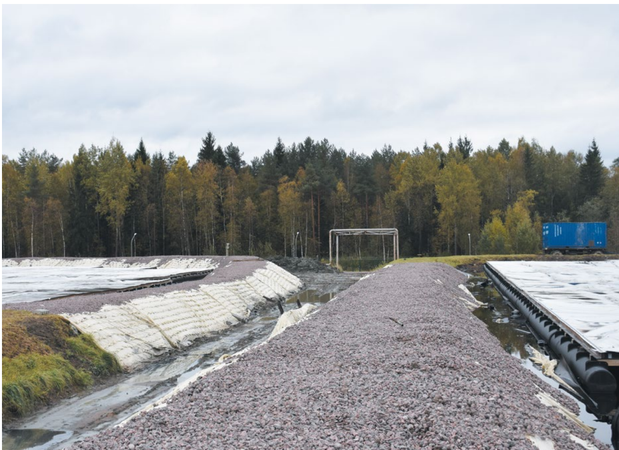
Отремонтированные дамбы обвалования
