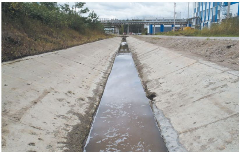
Внутренний канал после очистки. Сентябрь 2016 года
